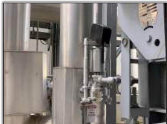
CRO แจ้ง OSM แรงดันไม่ลดลงหลังจาก Safety Valve ทั้ง 2 ตัวทำงาน และยังคงเปิดต่อเนื่องเป็นเวลานาน
